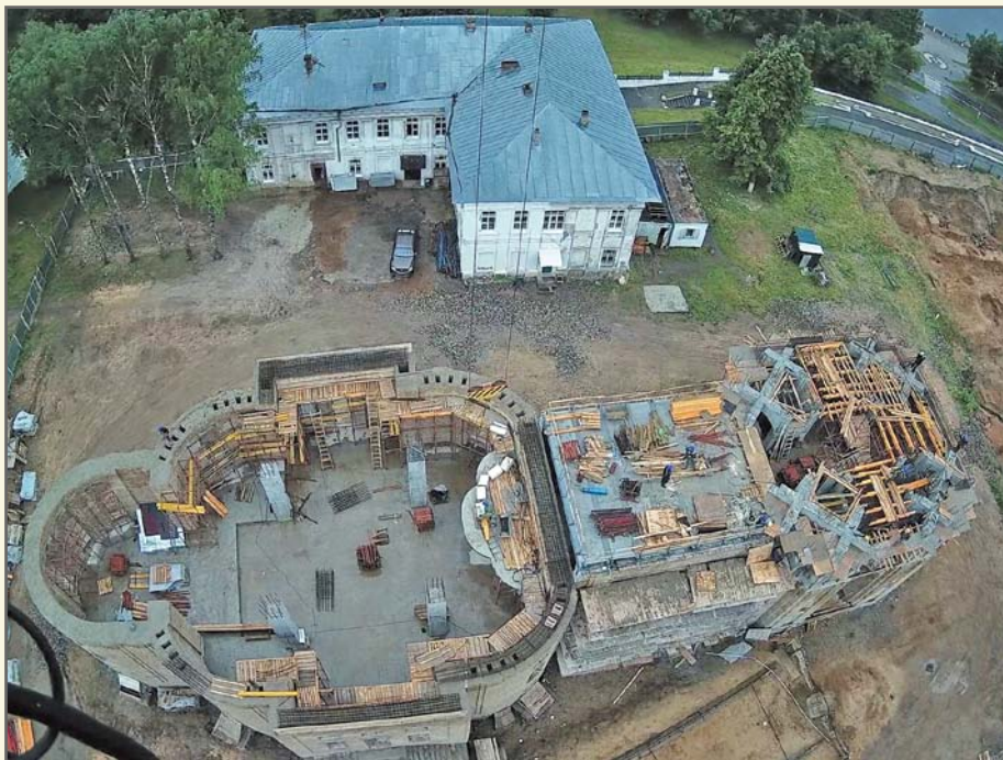
13 июля 2017 года. Вид на строительную площадку с башенного крана.
