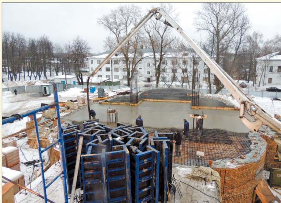
20 февраля 2017 года. Строительство Богоявленского собора.
