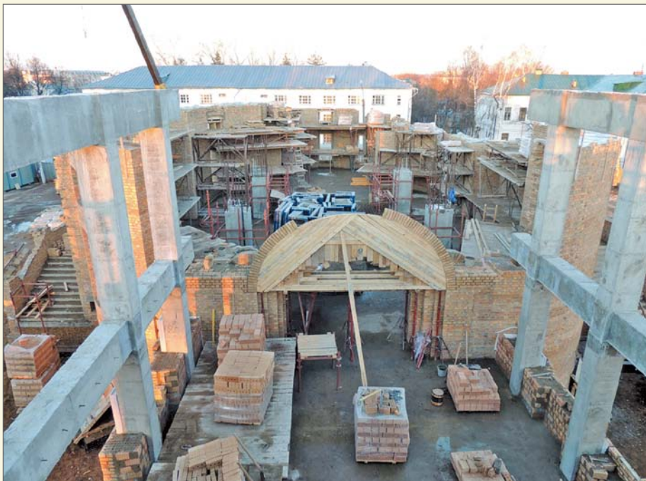
25 апреля 2017 года. Строительство Богоявленского собора.
