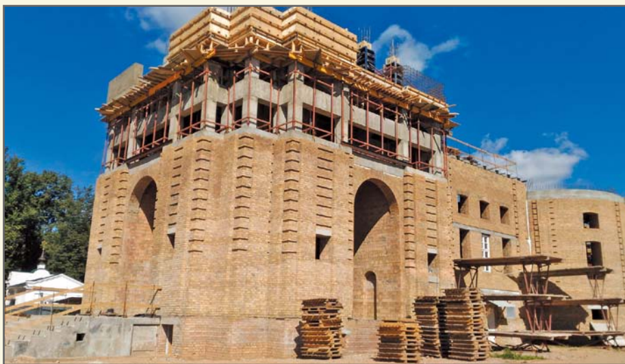
12 августа 2017 года. Строящаяся колокольня Костромского кремля.
