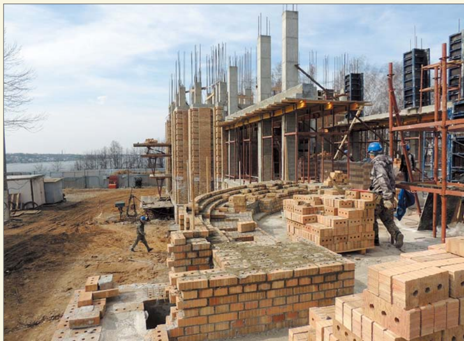
11 апреля 2017 года. Строительство Богоявленского собора.
