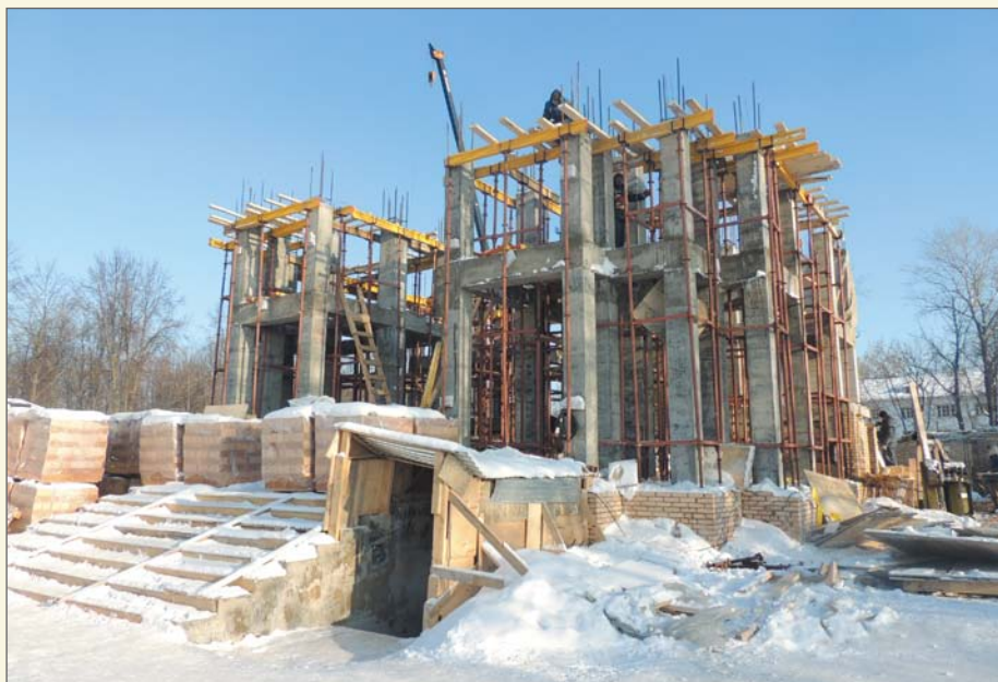
30 января 2017 года. Строящаяся колокольня.
