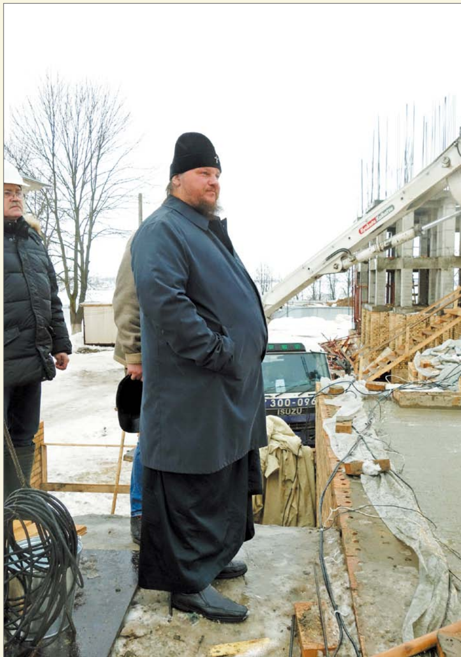
20 февраля 2017 года. Митрополит Костромской и Нерехтский Феропонт на строительной площадке Костромского кремля.
