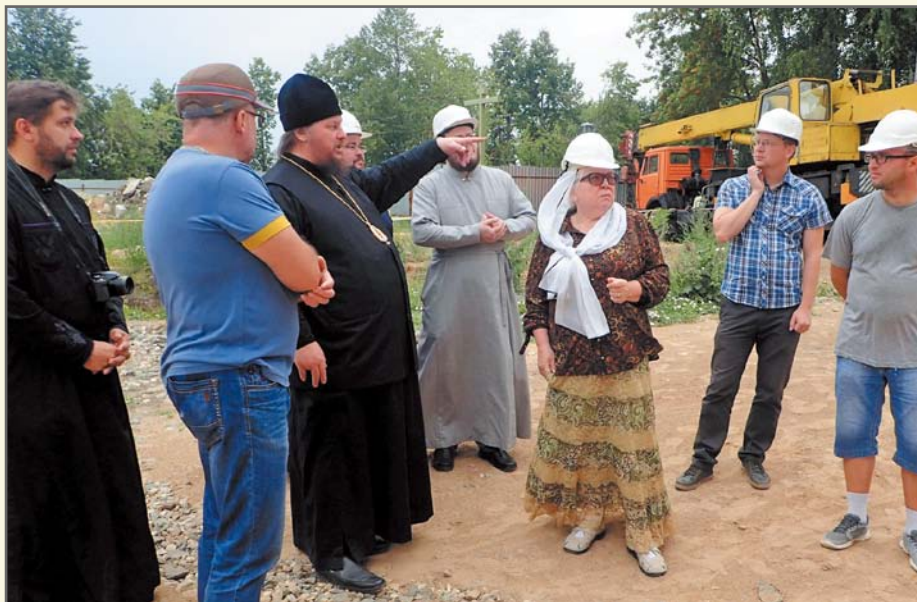
23 августа 2017 года. Митрополит Костромской и Нерехтский Ферапонт на строительной площадке кремля.
