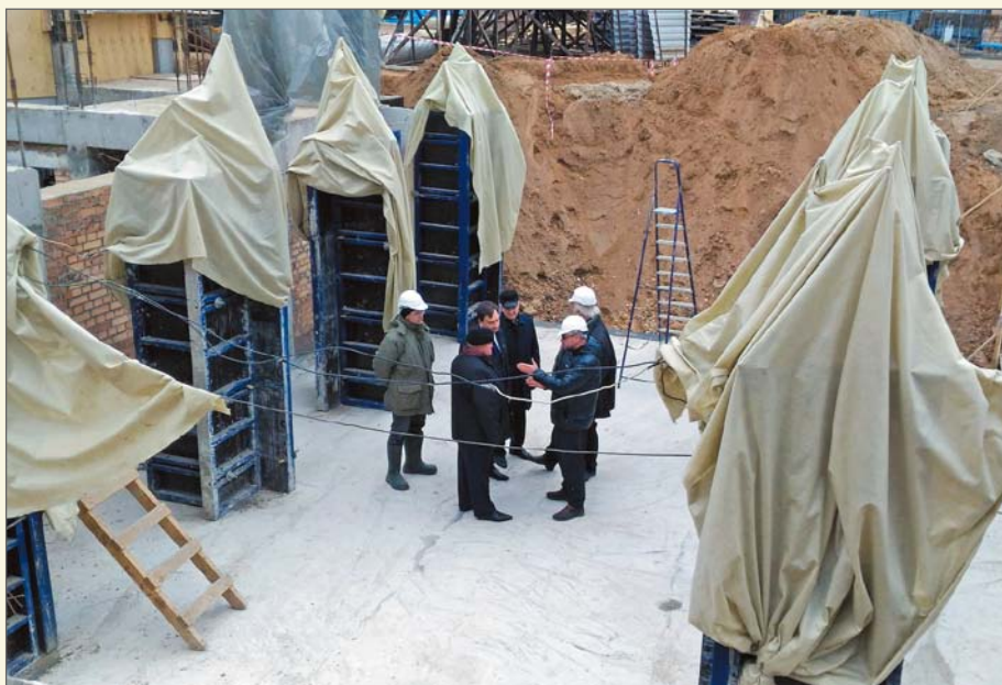
27 октября 2016 года. Губернатор Костромской области С. К. Ситников на строительной площадке.
